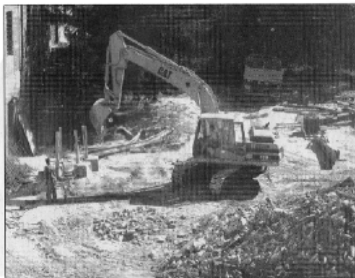
I lavori di costruzione del Centro Direzionale, fonte di polemiche da parte dei residenti
